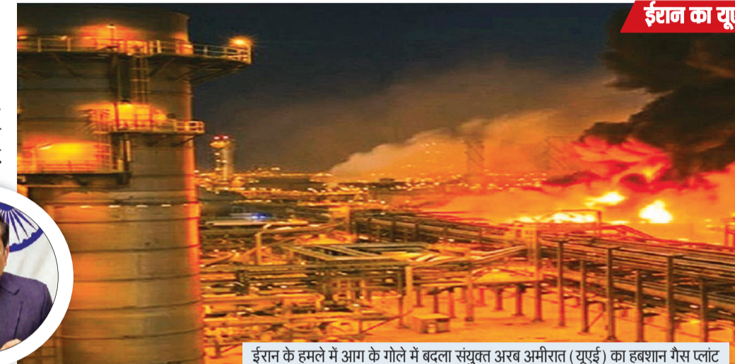
ईरान के हमले में आग के गोले में बदला संयुक्त अरब अमीरात (यूएई) का हबशान गैस प्लांट
